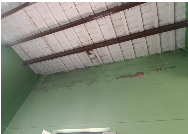
Revoques interiores y pintura a reparar (aula en esquina)
