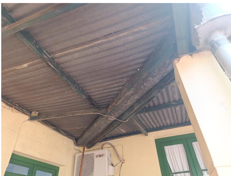
Cubierta de galería a sustituir
